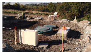
**RUE des PRUNIERs :** afin de viabiliser des terrains au niveau de la rue des pruniers, la commune de Mozac installe un poste de refoulement sur son réseau d'assainissement. Mise en service de l'installation fin octobre. *Coût des travaux : 70 000 € TTC.*
