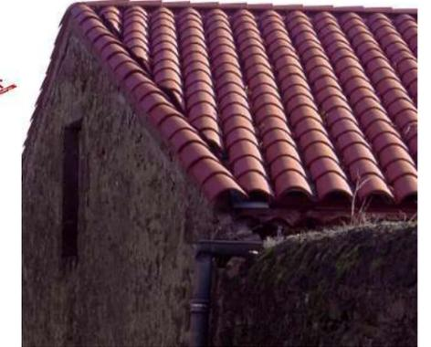
Dans ce cas, il peut être nécessaire d'arrêter la toiture selon un détail de ce type, qui permet d'amortir les formes trapézoïdales.
