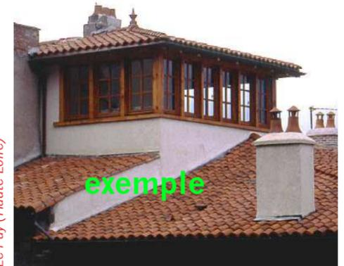
Les surélévations (lorsqu'elles sont possibles) doivent se faire selon les mêmes principes de pente de toiture que la construction d'origine.
