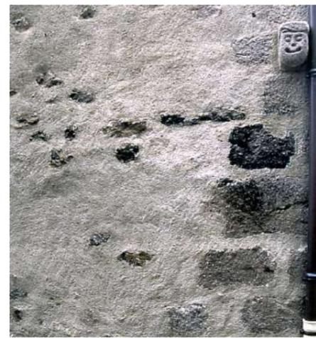
Lorsqu'un rejointoiment sera possible, il devra obligatoirement être réalisé à joints beurrés.
