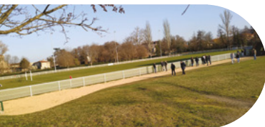
Travaux du complexe sportif : Terrain d'honneur
