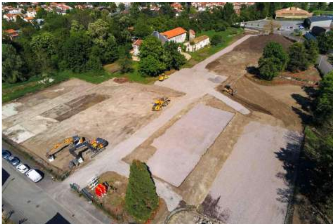
Photo drone du terrain pendant le terrassement
