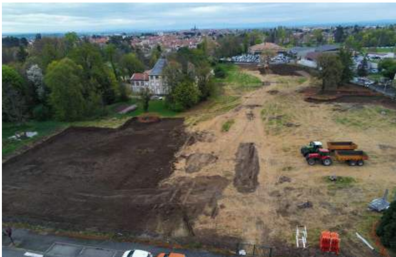
Photo drone du terrain au démarrage du terrassement
